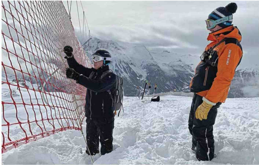
Dans la neige jusqu'aux genoux, notre rédacteur installe un filet de protection au bord des pistes.
